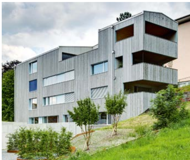
Fig. 6.7.1 Immeuble d'habitation au Kirchrainweg à Kriens (LU). La construction en bois de sapin blanc lucernois a reçu le prix énergétique Watt d'Or. Photo : Gabriel Ammon, AURA
